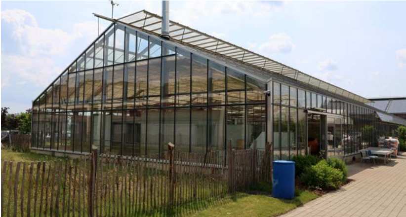
Ein Teil der neuen Anlagen in Limpach
